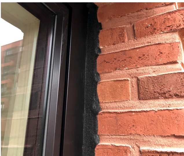
Einbaubeispiel: ISO-BLOCO 600 „MAXIBOND“
