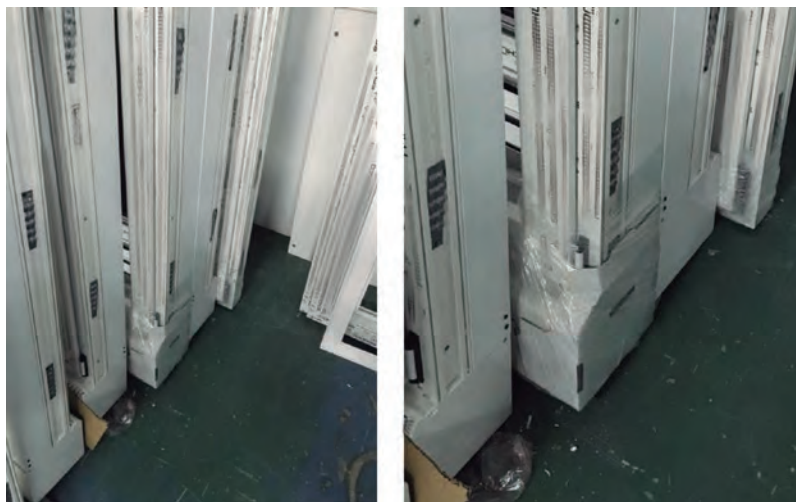
Figura 66. Detalle de ventana con cajón almacenada con el cajón hacia abajo, y embalada
