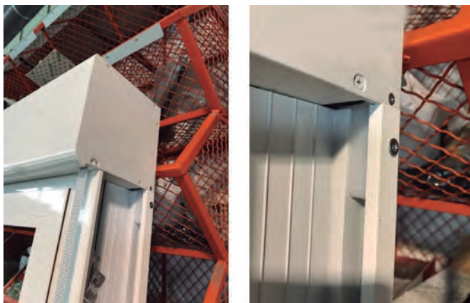
Figura 61. Embudo introducido en guía, con atornillado lateral
