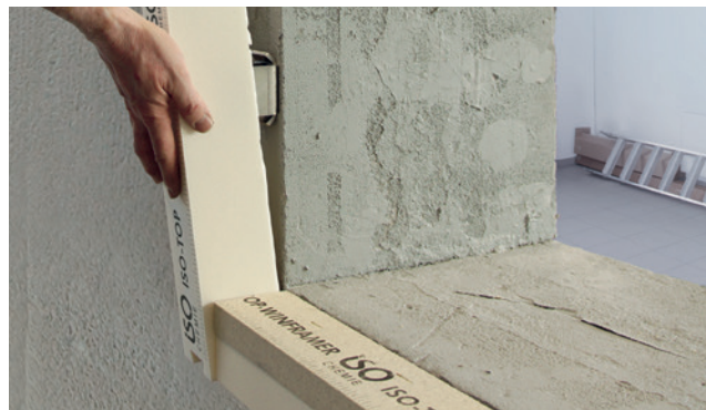
Przykład montażu: SYSTEM MONTAŻOWY W ZEWNĘTRZNEJ WARSTWIE IZOLACJI CIEPLNEJ ISO-TOP WINFRAMER „TYP 2”
