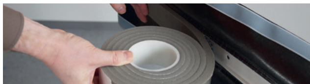
Przykład zastosowania: ISO 3 -SYSTEM USZCZELNIEŃ OKIENNYCH
