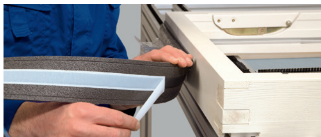
Przykład zastosowania (1-BT): montaż okien drewnianych
