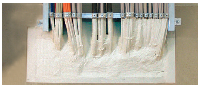
Przykład wbudowania: ISO-FLAME PLATTE S90
