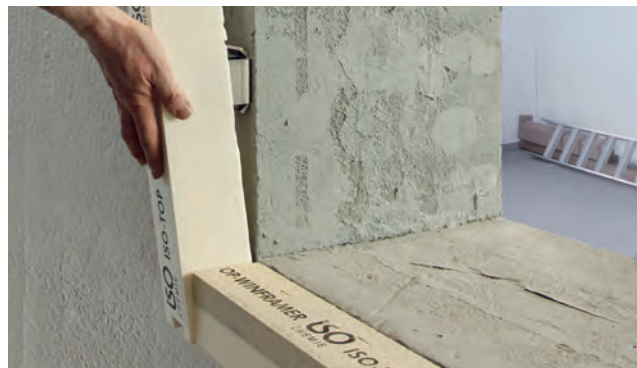
Primer vgradnje: PREDZIDNI SISTEM MONTAŽE ISO-TOP WINFRAMER „TIP 2“
