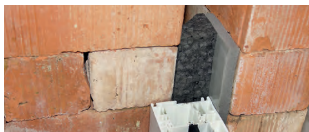
Primer vgradnje: ISO-BLOCO FILLER
