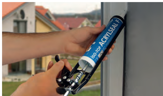
Primer vgradnje: ISO-TOP ACRYLSEAL F
