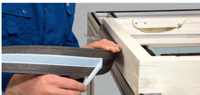
Primer vgradnje (I-BT): Montaža na leseno okno
