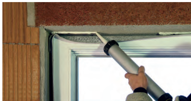
Primer vgradnje: ISO-TOP FLEX LEPILO SP
