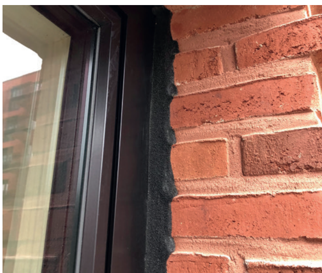
Einbaubeispiel: ISO-BLOCO 600 „MAXIBOND“
