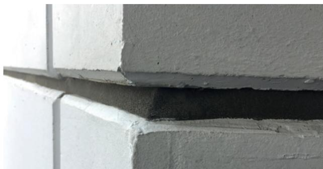
Ejemplo de instalación: ISO-BLOCO AIR
