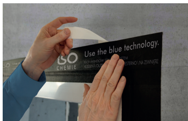
Ejemplo de instalación: ISO-CONNECT OUTSIDE CL
