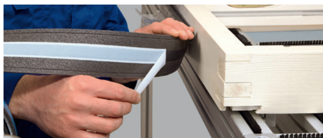
Esempio di installazione (I-BT): Montaggio su finestra in legno
