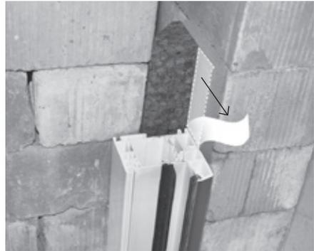
Blendrahmen gegen den Anschlag fixieren, (Klemmzwinde) so dass eine umlaufende Abdichtungsfuge  $\leq 6$  mm entsteht.
