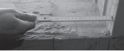
3. Fensterrahmenbautiefe und maximale Fugenbreite des Fensteranschlusses ermitteln.
