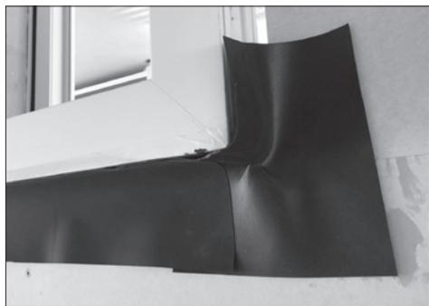
Im ersten Schritt sind die vorgeformten EPDM-Dichtecken an den zwei unteren Elementecken auf der Wand mit zwei Kleberrauten und am
