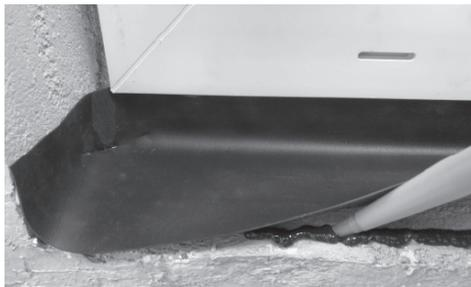
Die Höhe der Abdichtungswanne soll bei normalen Fenstersystemen zur Ausbildung der 2. Dichtebene bis mindestens an die Unterkante des waagerechten Blendrahmenprofils geführt werden. Entwässerungsöffnungen dürfen dadurch nicht überdeckt werden.
