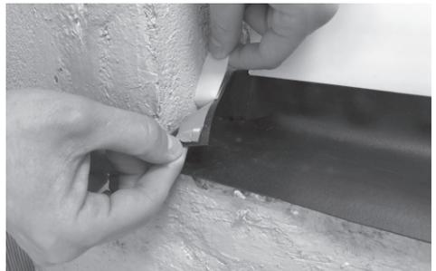
Trennpapier vom Selbstklebestreifen entfernen, dann Folie am sauberen und trockenen ggf. mit Primer vorbehandeltem Untergrund anlegen und kräftig anwalzen (Verarbeitungstemperatur laut Datenblatt beachten). Bei stark unebenen oder porösen Untergründen ggf. Glattnstrich einbauen.
