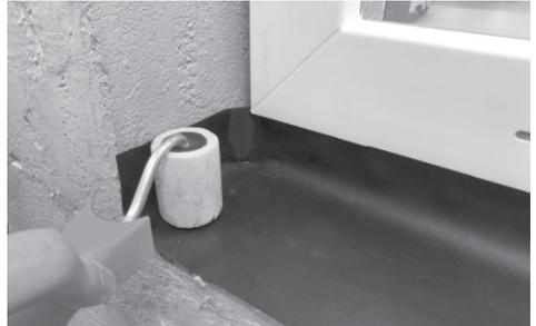
2. Anbringung an Baukörper bei optional vorhandenem Butyl-Selbstklebestreifen.
