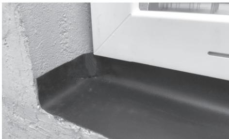
Die Verklebung hindert die Dichtwanne daran, bei Winddruck angehoben zu werden und verhindert, dass Wasser durch Winddruck unter die Abdichtungsebene gedrückt wird. Dadurch ist an der vorderen Abdichtungsebene eine durchgängige Verklebung auszuführen.
