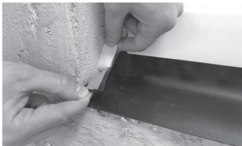
Kleinere Unebenheiten an Laibung oder Brüstung können bei der Verklebung mit ISO-TOP FLEKKLEBER XP durch einen höheren Kleberauftrag ausgeglichen werden. Bei der Verwendung der optional lieferbaren Butyl-Selbstklebestreifen muss ggf. ein Glattstrich erfolgen.
