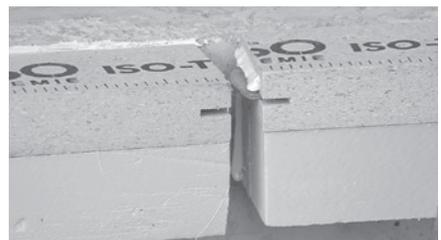
Zusätzlich werden die Systemwinkel umlaufend mechanisch verschraubt (Schraube mit Zulassung). Zur verdeckt liegenden Befestigung wird der Dämmkeil am Verbindungsstreifen, der wie ein Scharnier funktioniert, weggeklappt. Die Befestigungsschrauben
