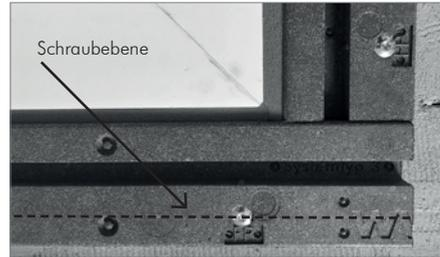
Die Schraubenköpfe nur zur Hälfte im Material versenken. Können die Verschraubungspunkte an den Markierungen nicht genutzt werden gilt folgende Aufteilung:
