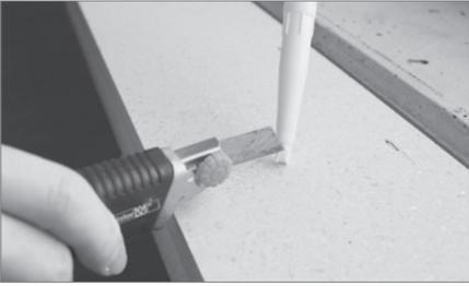
Der Kleberauftrag erfolgt auf der Rückseite der Systemkante, wie auf nachfolgendem Bild zu sehen.
