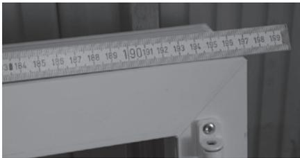
4. Seleccione la dimensión de la cinta según la profundidad de construcción del marco de la ventana y el ancho de junta (véase el etiquetado del cartón).
