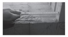
3. Determine el ancho de perfil de la ventana y la máxima anchura de la junta entre ventana y muro.
