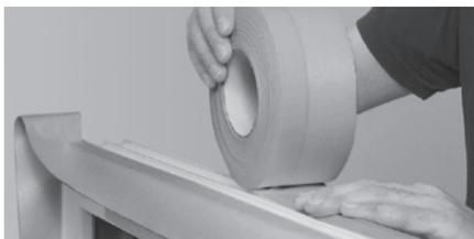
Il est également possible de réaliser la découpe d'angle de la membrane de raccordement de fenêtres par superposition. La superposition doit s'élever à 50mm minimum.
