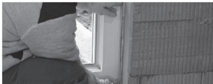
5. Les zones à enduire nécessitent si possible un collage sur toute la surface. Il est nécessaire de laisser une surface de membrane non collée de max. 20 mm pour garantir une marge de mouvement suffisante.
